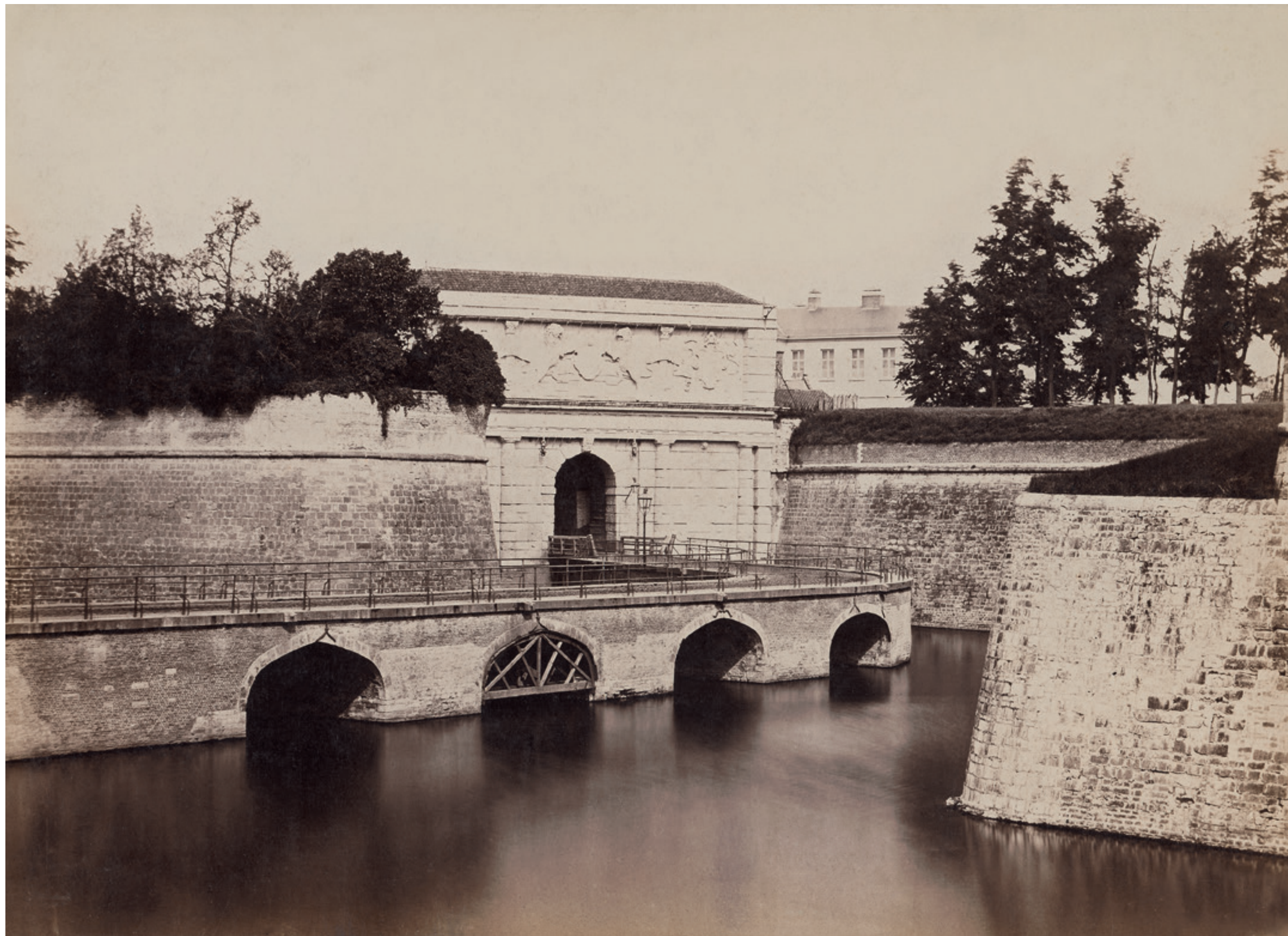
Edmond Fierlants. Sint-Jorispoort, buitenzicht met vestinggracht, 1860 - Porte Saint-Georges, vue de l'extérieur avec fossé de fortification, 1860
